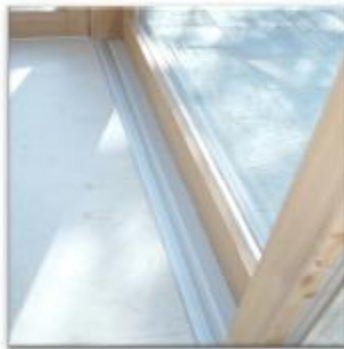
Schiebetür Geschlossen mit Blick auf Laufschiene
