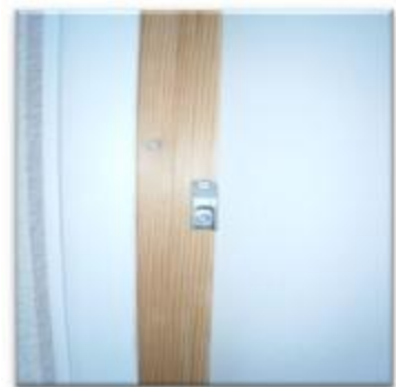
Fenster / Fenstertüren Detailfoto eines Schließstückes (feststehende Rahmenseite)
