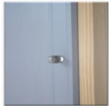
Schiebetür Detailfoto eines Verschlusspunktes
