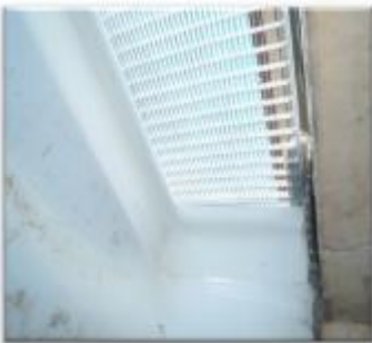
Lichtschartrost Foto im geöffneten Zustand von unten nach oben mit Blick auf seitliche Lichtschartwand
