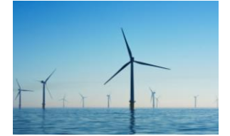
ERNEUERBARE ENERGIEN Offshore-Windpark in den Niederlanden
